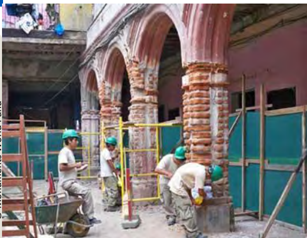
Obra de restauración
