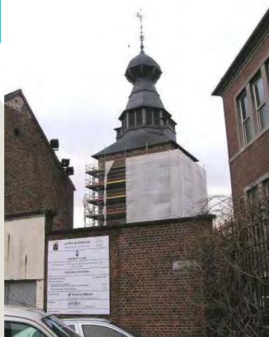
Le chantier de restauration des façades du beffroi
