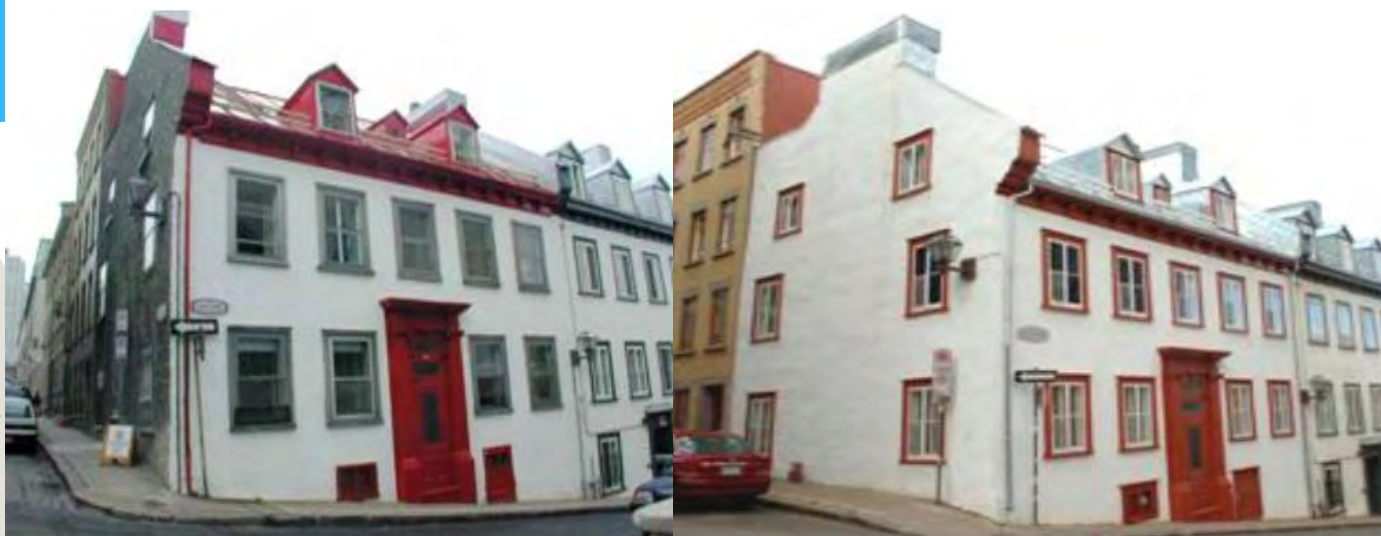
Avant/après : un bâtiment patrimonial restauré dans l'arrondissement historique du Vieux-Québec grâce au programme « Maître d'œuvre »
