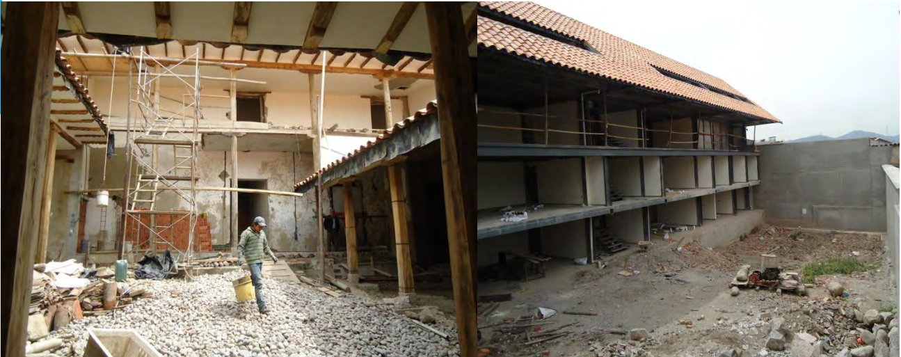
Obras en la calle Rafael María Arízaga
