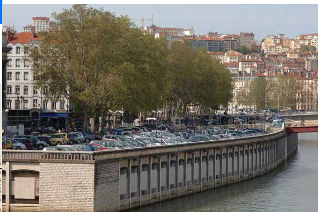
Un parc de stationnement à démolir dans le centre historique de Lyon
